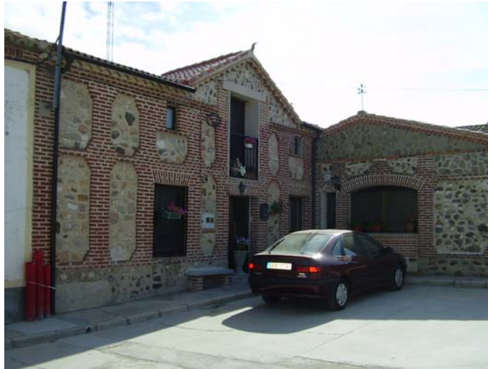
Fachada a proteger
