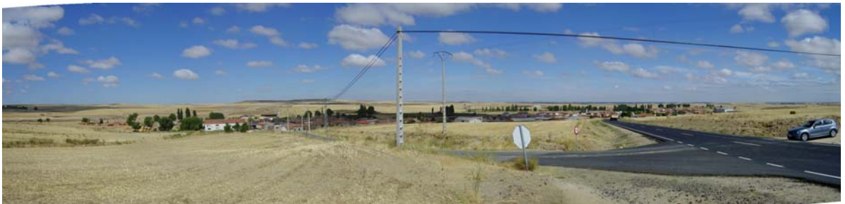
Panorámica de la entrada de las infraestructuras en el Núcleo Urbano
