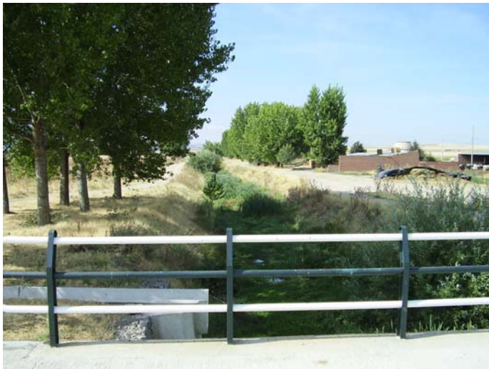
Puente sobre el Río La Berlana
