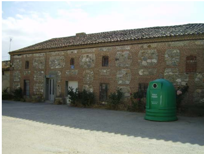
Fachada a proteger
