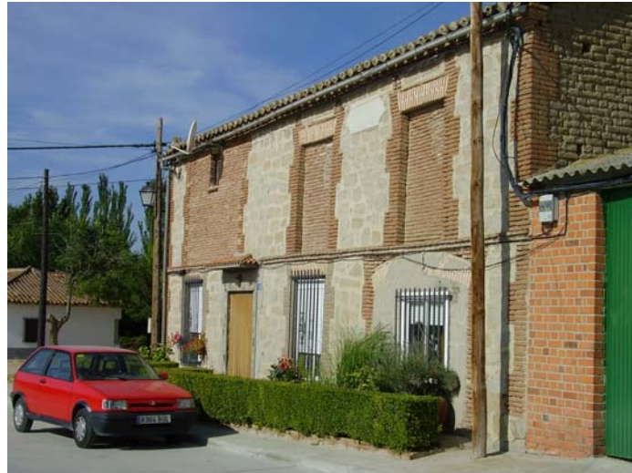
Fachada a proteger
